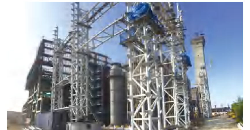
▲ 印尼泗水在建垃圾热解气化发电项目
